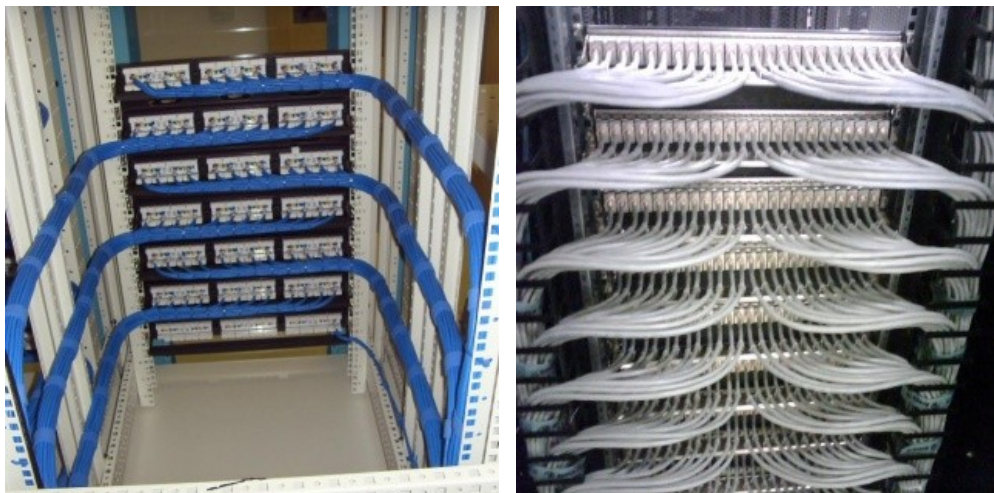
Fig. 3: Detalhe da organização de cabos UTP no rack já conectorizados.
