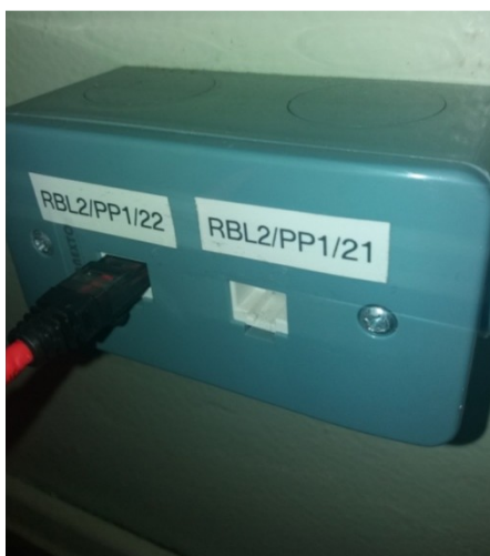
Fig. 5: Ponto de rede x2 devidamente identificado.
